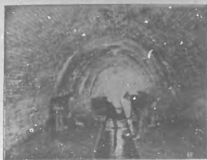
Limpieza diaria de la colectoría principal.
